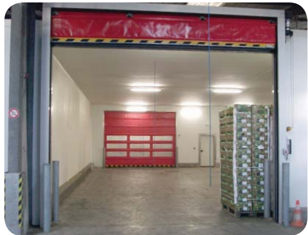
Fold-Up rapid doors, handle operated Fruit and vegetable industry (Perpignan, France) Portes rapides à empilement avec tirettes Industrie maraîchère (Perpignan, France) Schnellfaltore, die mit Seilzugschalter betätigt werden Obst- und Gemüseindustrie (Perpignan, Frankreich)
